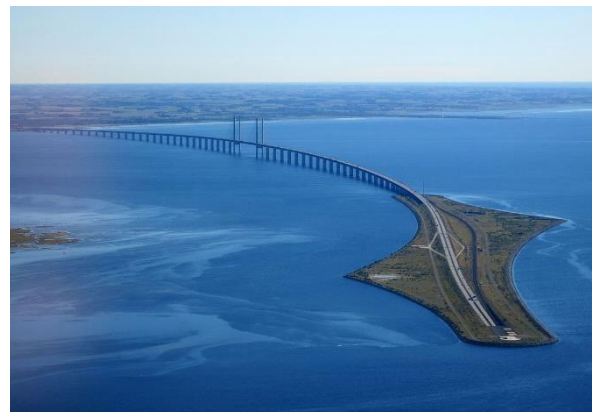
Da cidade de Malmö para Copenhague pela Ponte Öressund, são 3 trechos bem definidos: 1) uma ponte estaiada sobre o mar com 7,84 km; 2) uma ilha artificial com cerca de 4 km de pista, formada por rochas, areia e entulhos da construção; 3) a estrada mergulha no mar, através de um túnel de quase 4km.
