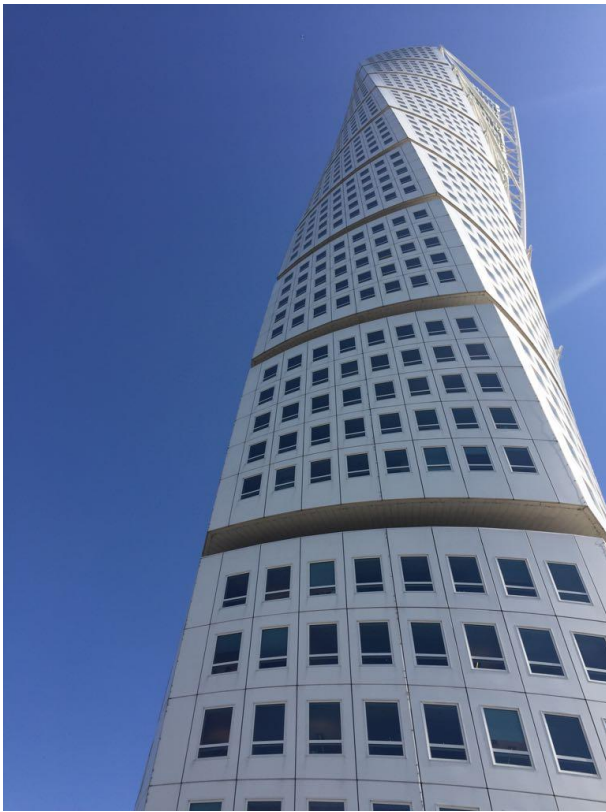
O Edif. Turning Torso faz um giro, uma torção de 90 graus da planta térrea até a cobertura
